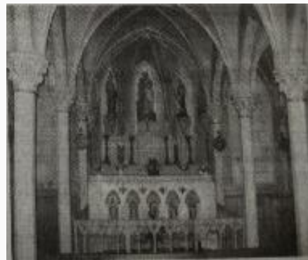
Vue intérieure : nef, colonnes et autel restauré
